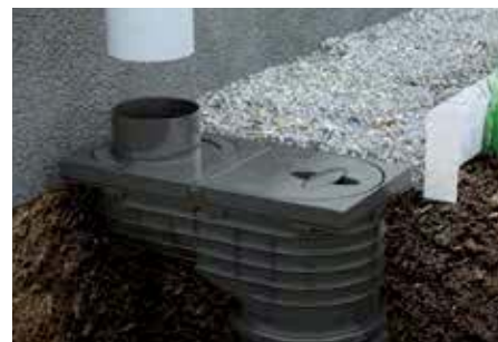
3. Napojte dešťové odpadní potrubí
